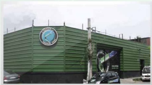
Instalaciones Koalition SA
